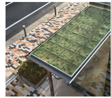
お店の屋上や 駐輪場の屋根に 植物を植えて緑化
