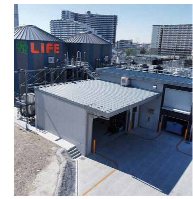
バイオガス 発電設備を 運用
